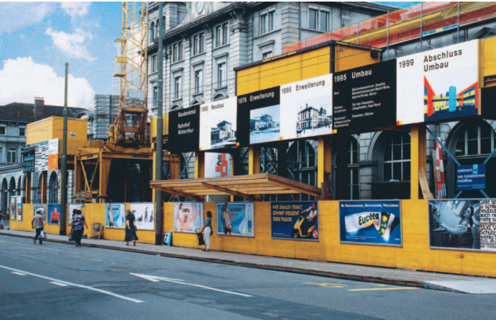
Umbau Bahnhof Winterthur
