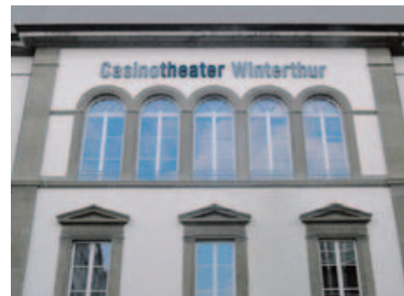
Umbau des Casinotheaters in Winterthur.
